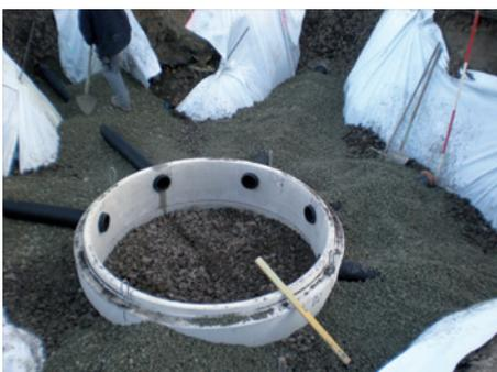
Abbildung 4: Sammelschacht SS 2 mit Biofilter (Rindenmulchgemisch).
